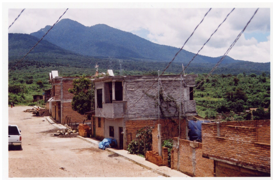
Obras inconclusas en un extremo de Santa Fe
