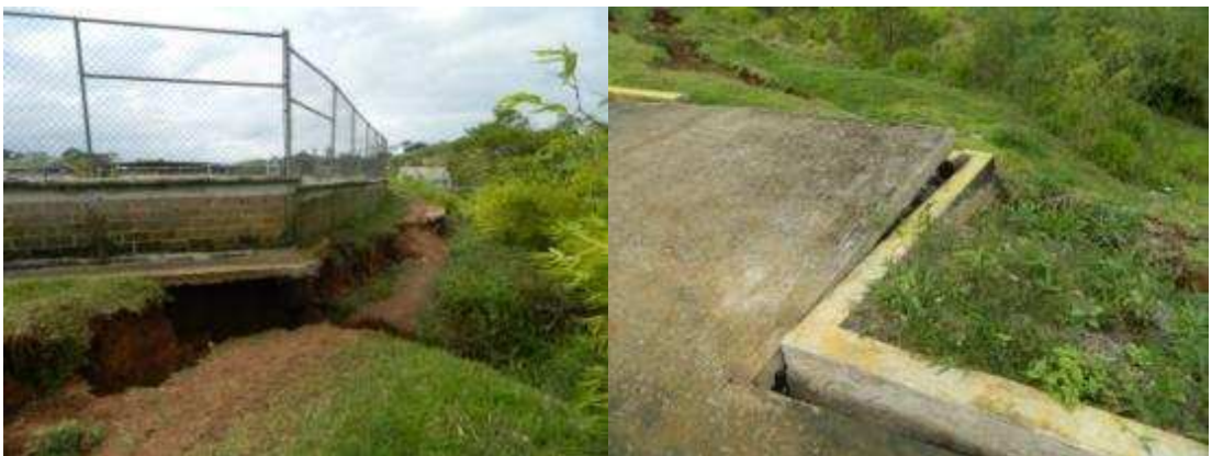
Foto 3 y 4. Movimientos de tierra.
