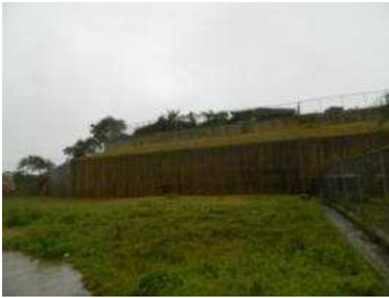
Foto 5: Muros de contención.
