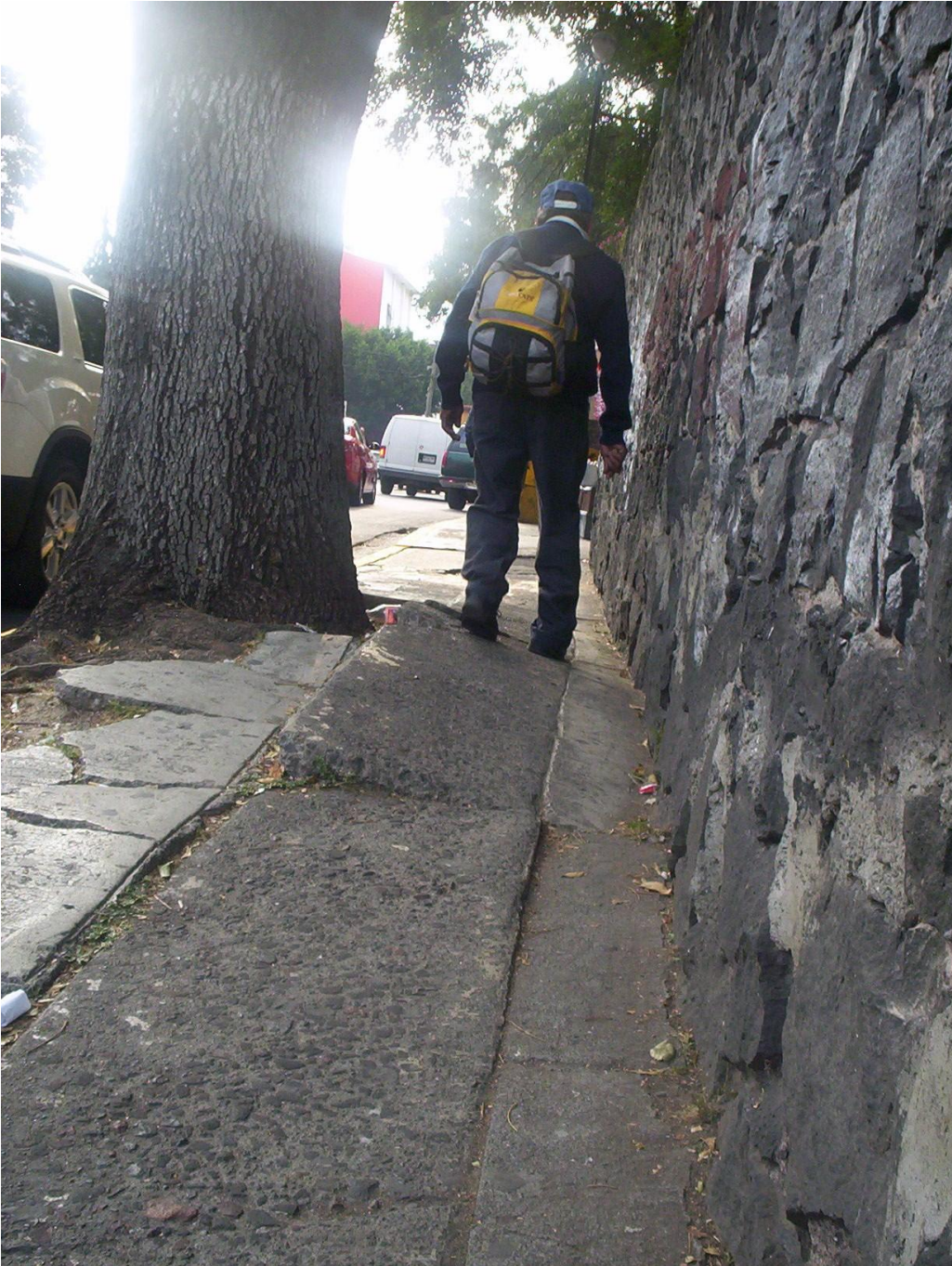
Ilustración 21: Banqueta rota y ladeada por el crecimiento de una raíz de árbol. Foto: Mariana Hernández Flores, octubre de 2009.
