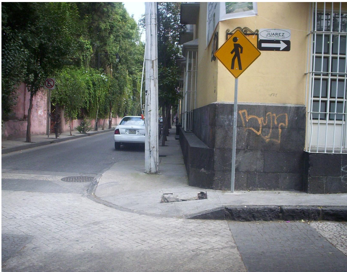
Ilustración 24: Rampa con coladera que tiene un hoyo, ejemplo de eslabón aislado de accesibilidad. Foto: Mariana Hernández Flores, octubre de 2009.
