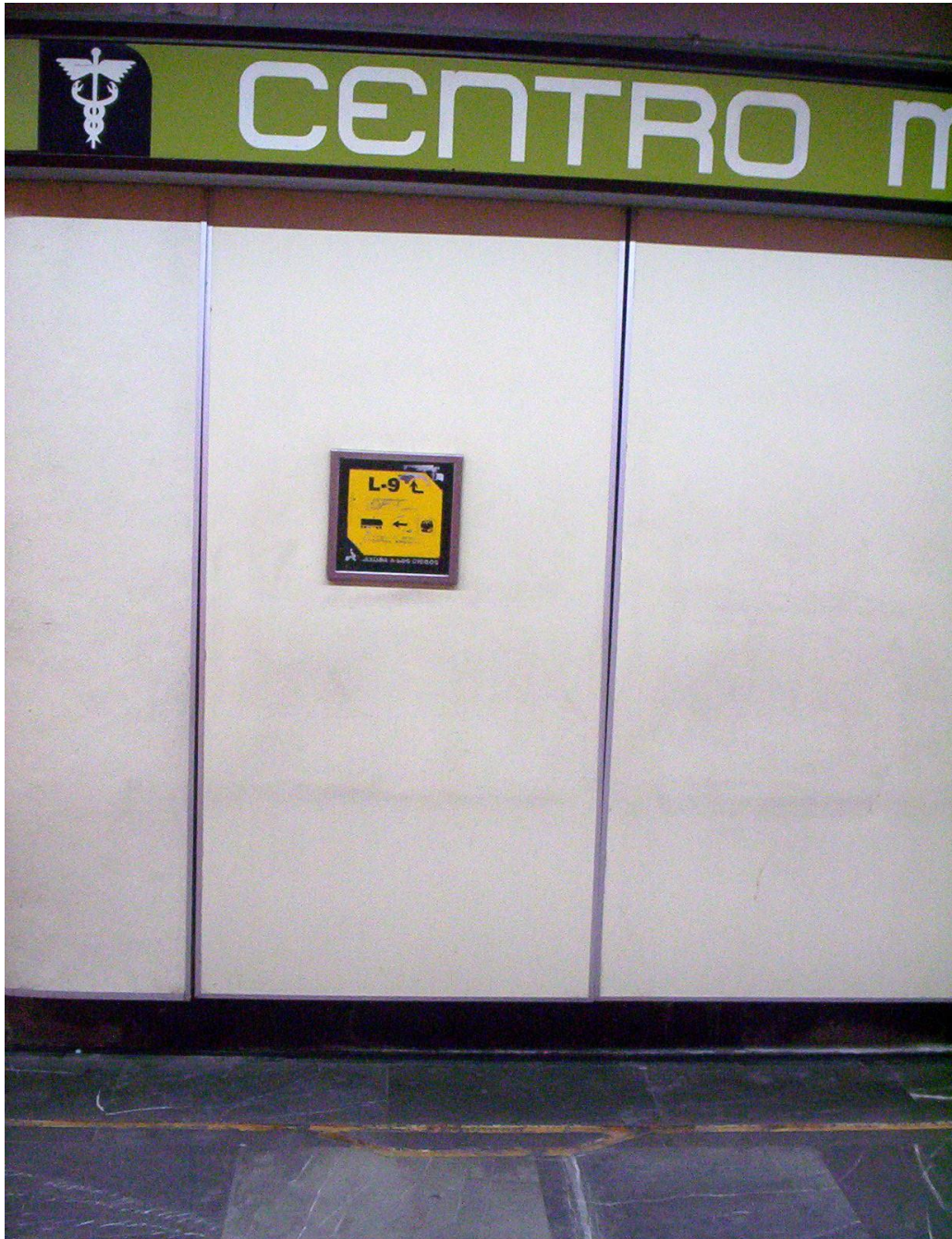
Ilustración 20: Placa braille pegada a la pared lo que provoca una postura incómoda de la mano para leer la información.
