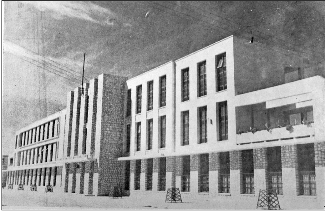
65. Centro Educacional Felipe Carrillo Puerto, fachada oriente (principal). [Album del Centro Educacional Felipe Carrillo Puerto, 1945]
