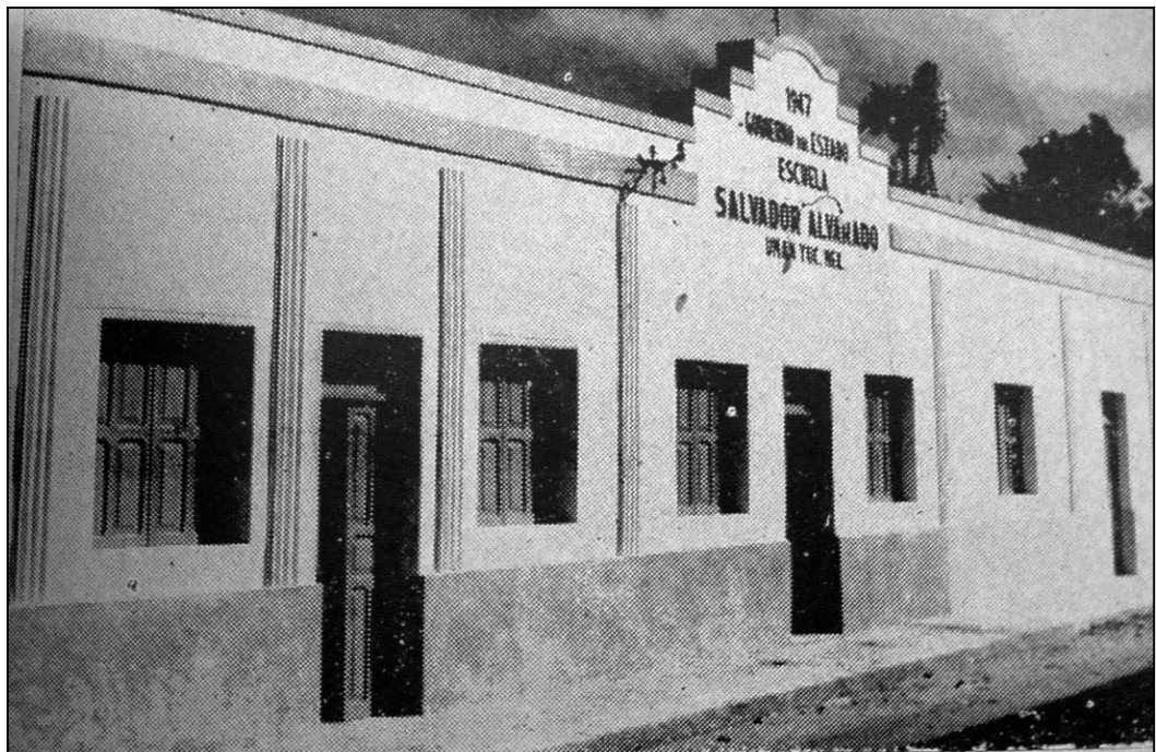
82. "Edificio de la Escuela Salvador Alvarado", de Umán. [González Beytia, 1948]
