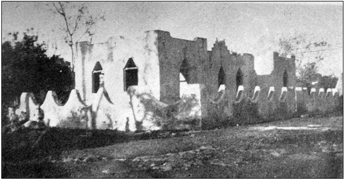
85. "Escuela de Kanxoc, en construcción". [González Beytia, 1950]
