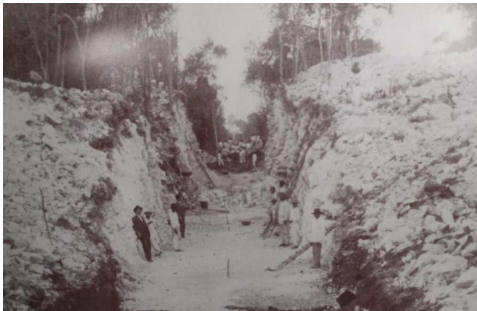
Fotografía 4. 2. Tajo en el kilómetro 148 de la vía del tren Mérida-Peto. Fuente: Memoria que contiene datos históricos y estadísticos y una colección de fotografías de las estaciones y planos del ferrocarril de Mérida a Peto con ramal a Sotuta, formada para la exposición de París que se verificará el año de 1900 , Mérida, Imprenta Loret de Mola, 1899.
