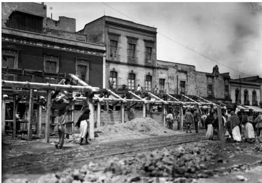
Construcción de puestos del mercado. Fuente: Fototeca INAH, núm. 2673
